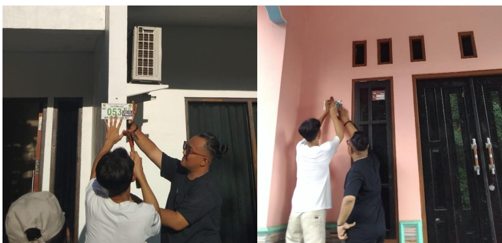
Gambar 2. Pemasangan plat penomoran rumah warga
